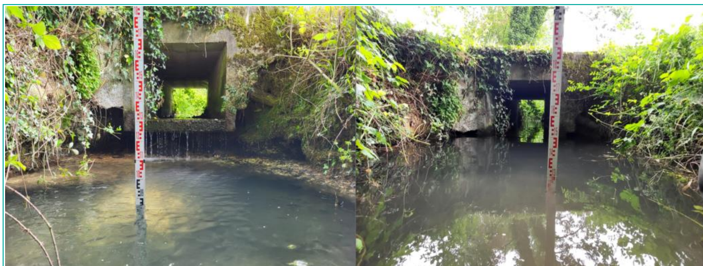
Photos avant et après travaux, montrant le rehaussement de la hauteur d'eau
