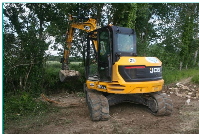
Travaux de recharge granulométrique
